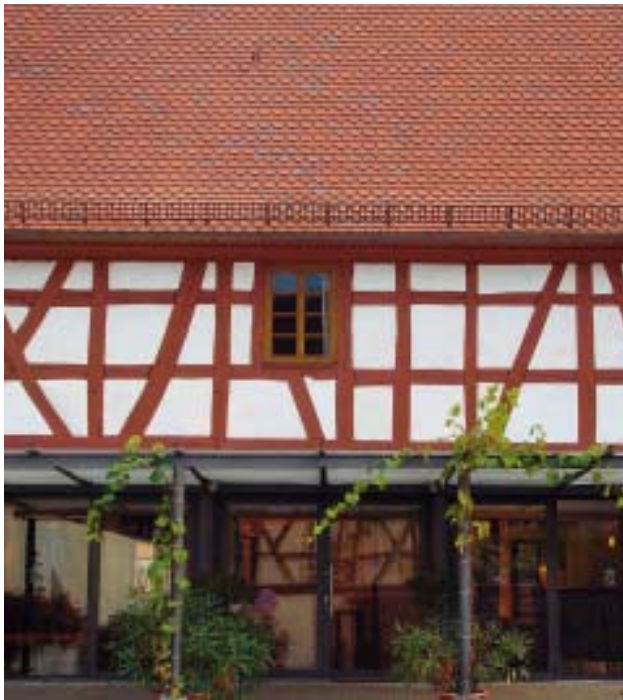
Bei Fachwerkhäusern wurde die Holzkonstruktion zum prägenden Stilelement. Hier ein behutsam umgebautes und modernisiertes Beispiel. (Architekt: Matthias Zöllner, Neustadt/Weinstraße)
